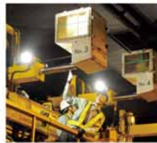
通行車の走行車線を確保しながらの点検実施中
